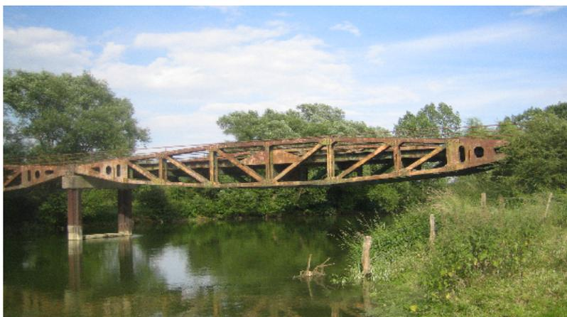
Des ponts « baleine » ( whale ) étaient posés sur deux caissons flottants et formaient une chaussée pour mener les camions des pontons à la plage ( ici réutilisé sur la Meuse )
